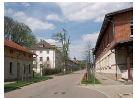
Blick ins „Alte Lager“ auf dem ehemaligen Truppenübungsplatz in Münsingen.
