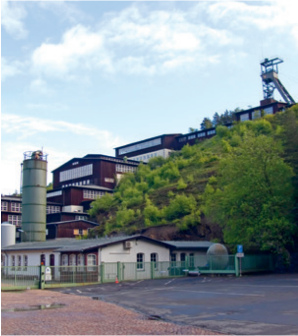
Bergwerk Rammelsberg Mines of Rammelsberg
